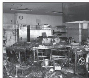
津波により使用不能になった調理室。【宮城県仙台市立東六郷小学校・月刊「学校給食」2011年9月号】
